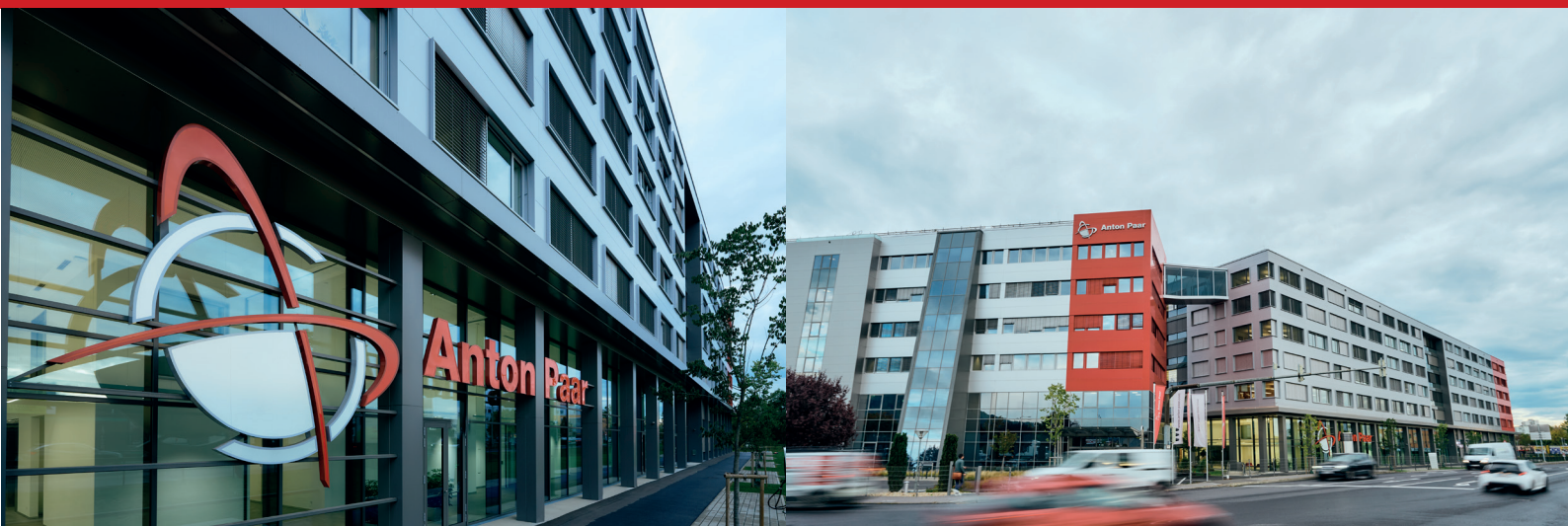
Headquarter mit Technologiezentrum in Graz, Österreich (2025)
