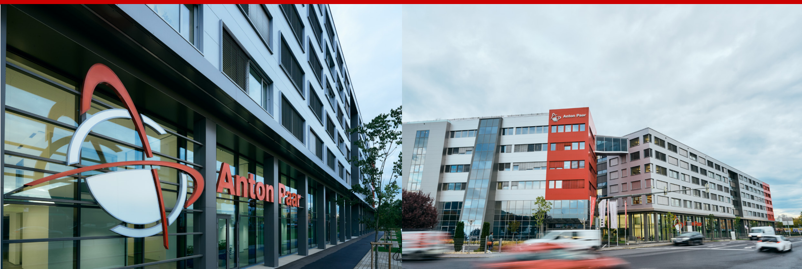
Headquarter mit Technologiezentrum in Graz, Österreich (2025)
